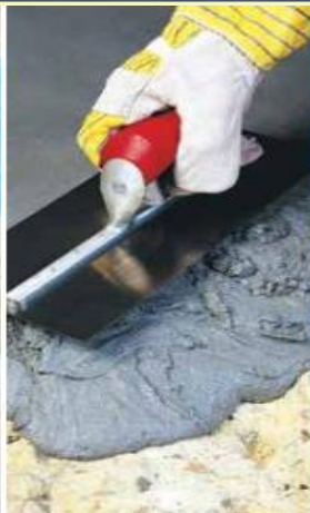
JOINTS ET MORTIERS
