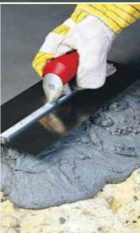
JOINTS ET MORTIERS
