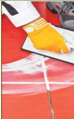
REVÊTEMENT DE SOL ET CARRELAGE
