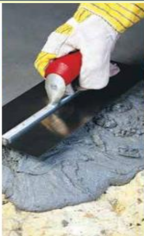
JOINTS ET MORTIERS
